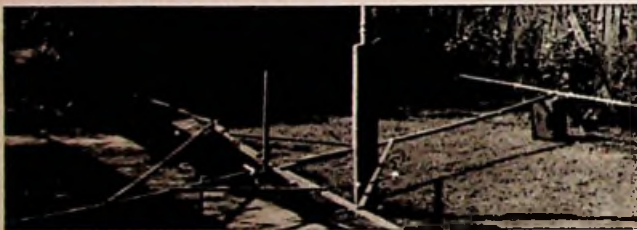
Abb. 9. Gekreuzte 8JK-Antennen für die vier Hauptrichtungen, mit umschaltbarer, abgestimmter Speiseleitung; gewinkelte Elementenden; 9 m lange Kreuzbalken 2,5x5 cm aus Holz
